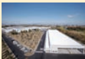
埼玉本庄工場敷地内に完成した「本庄第3工場」
