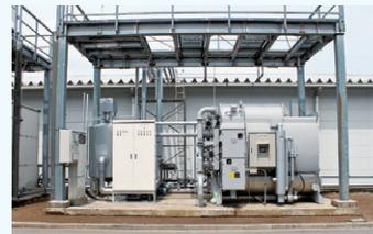
2台目の排熱回収式吸着冷凍機
