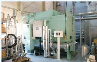
1台目の排熱回収式吸着冷凍機
