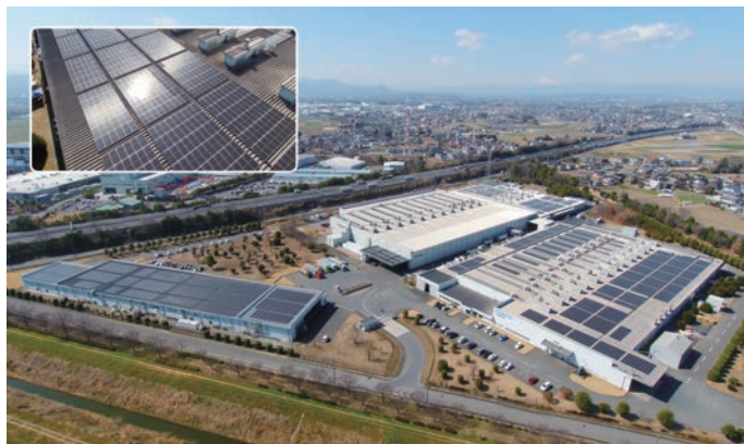
工場に設置された太陽光パネル
